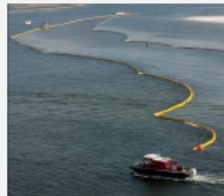
Figure 7-3. Barreiras de contenção para controlo de derrames
